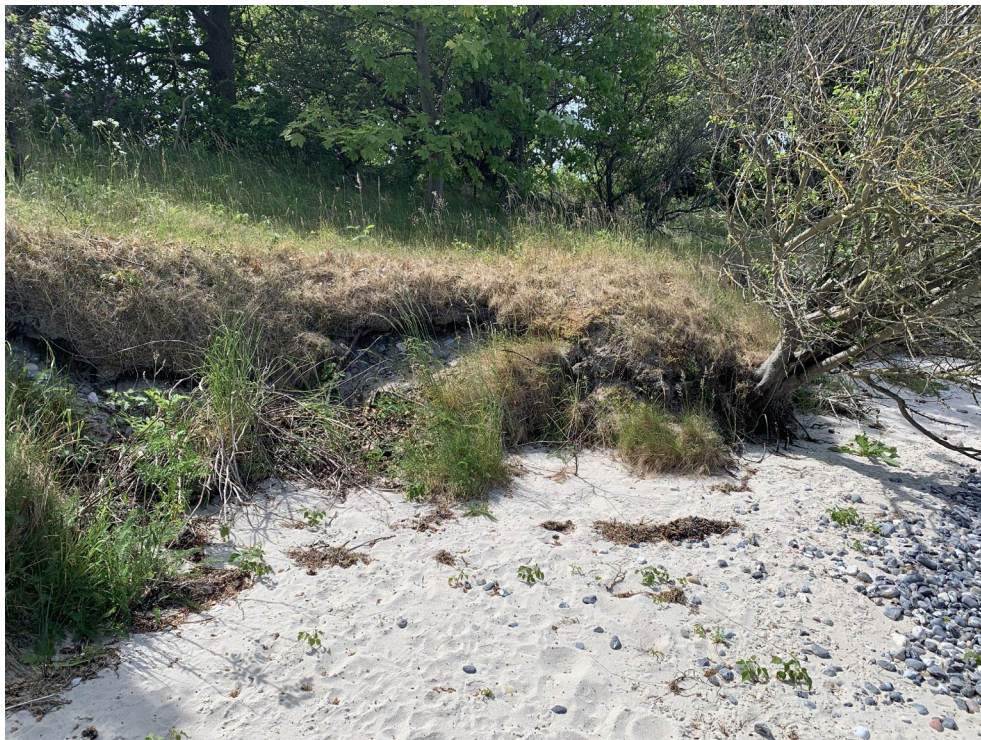
Figur 20 Digets tilstand ved st. 1360 set i retning mod vest
