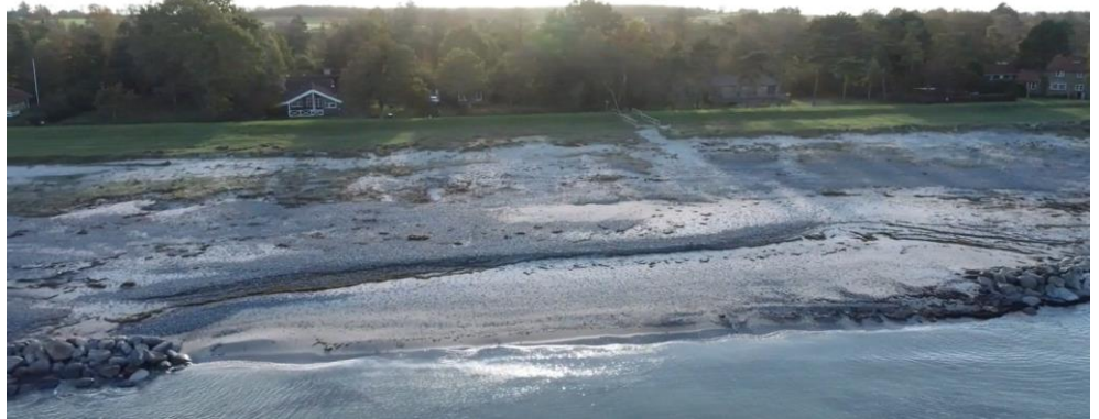
Figur 4-3 Relativt uberørt dige, beskyttet bag de vestligst placerede bølgebrydere og forstrand. Foto fra Ulvshale-Fællesskov digelag efter stormen Babet.
