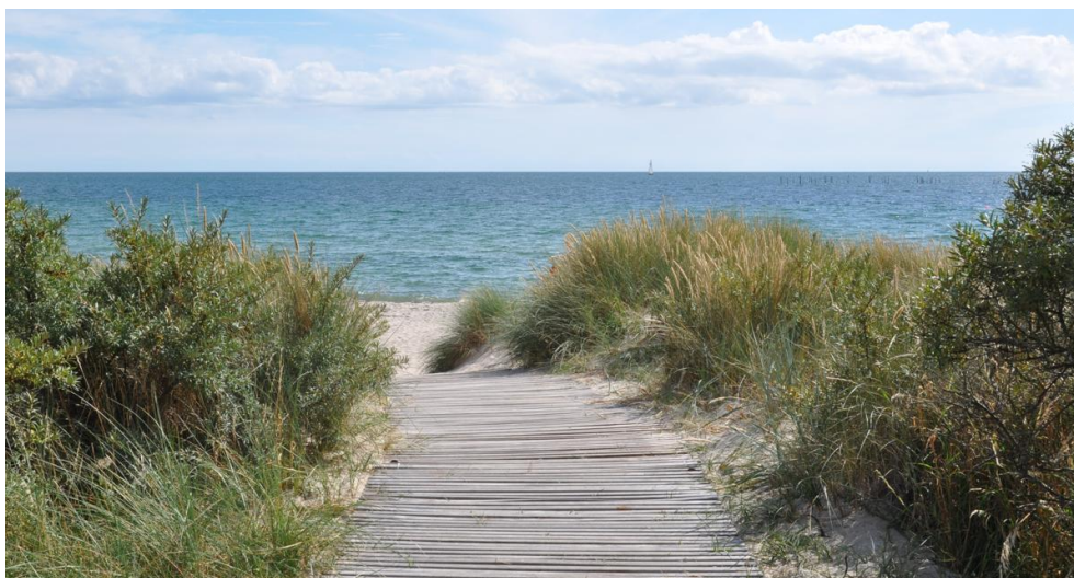
Figur 2-23 Terrænmåtter kan etableres ved adgangsveje hen over diget for at minimere menneskeskabt erosion. Fotoet er taget ved Klintholm Havn på Møn af Peter Fløcke Klagenberg
