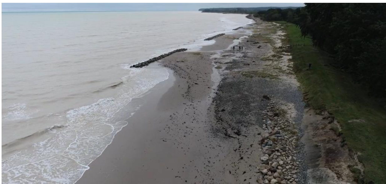
Figur 3 foto fra ansøgning, der viser beskadiget dige på strækning uden foranliggende bølgebrydere, og mere uskadt dige bag foranliggende bølgebrydere
