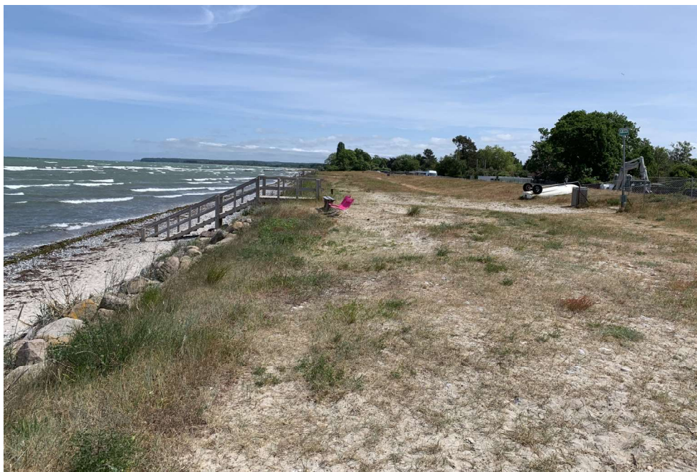
Figur 18 Diget ved st. 1800, set i retning mod sydøst med tydelig nedtrampet sti ved trappen
